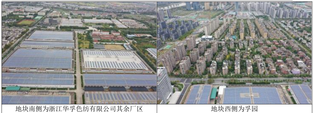
图 2.5-1 地块周边现状
