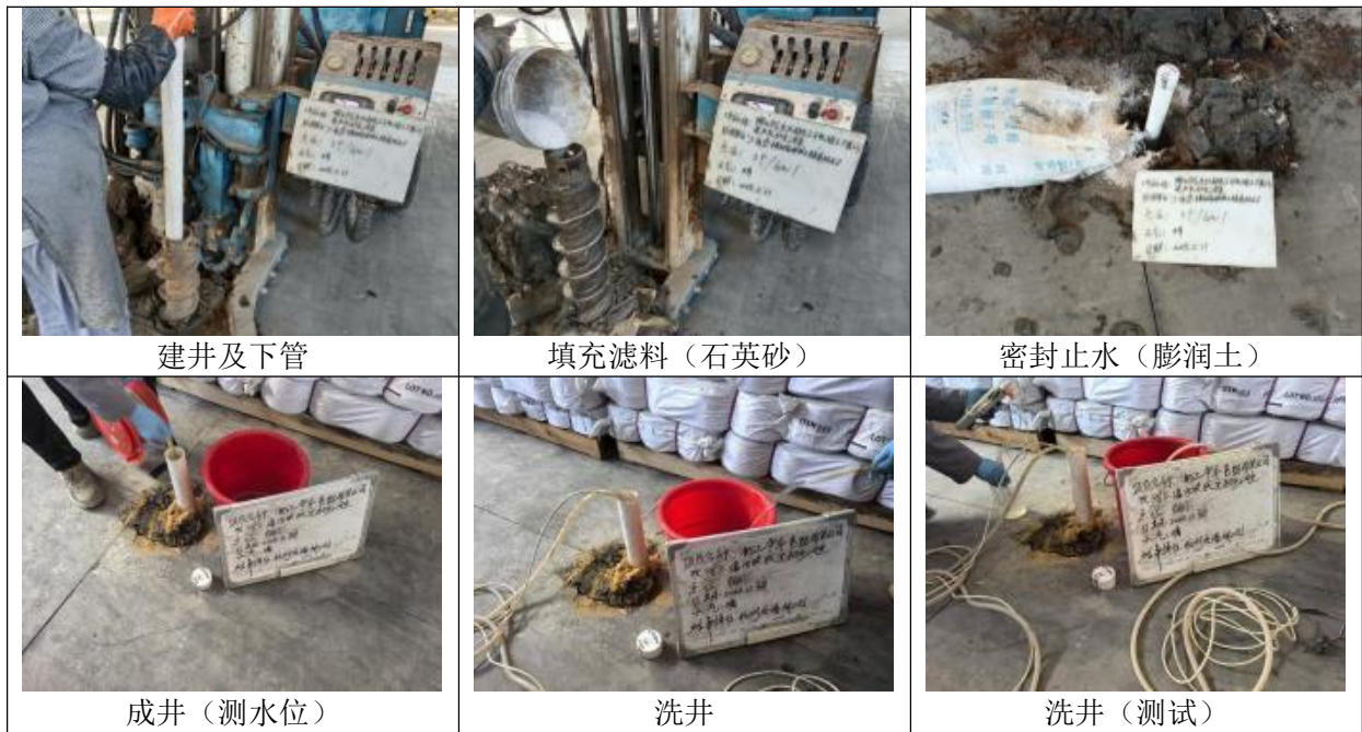
图 5.2-2 地块地下水成井洗井照片（以 GW1 点位为例）
